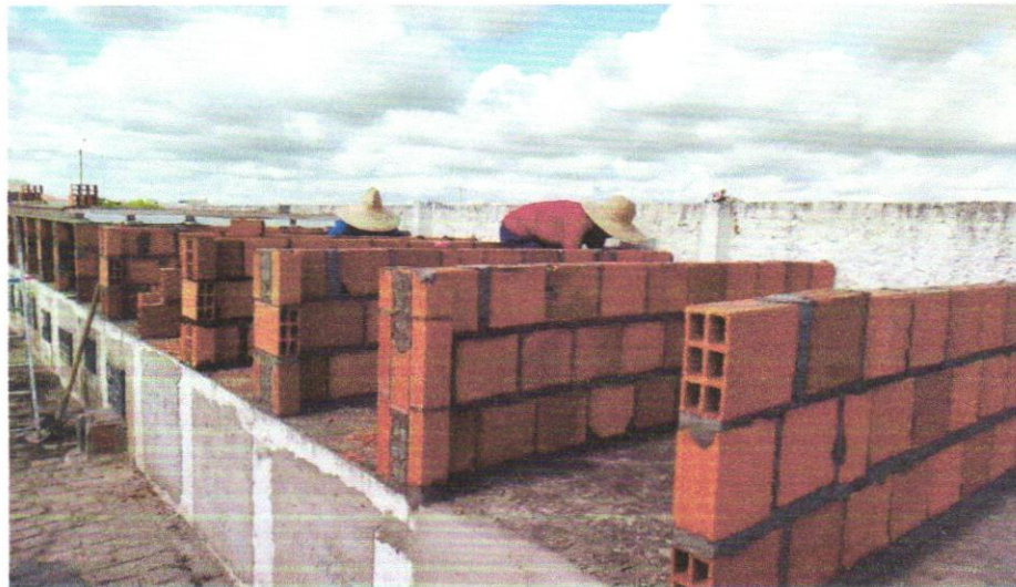
FOTO 03 - Alvenaria bloco cerâmico vedação, 9x19x24cm, e=9cm, com argamassa t5 - 1:2:8 (cimento/cal/areia), junta=1cm - Rev.09
